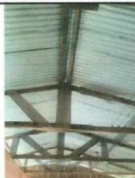
Foto 6: En esta parte del techo también hay filtraciones de agua cuando llueve. No están totalmente encajadas las láminas con las costaneras y los capotes.
