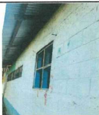
Foto 3: Otra panorámica de las ventanas, donde se observa que no cuentan con balcones.
