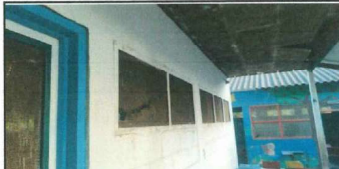
Foto 4: En esta parte se observa que tampoco hay balcones en las ventanas del salón.
